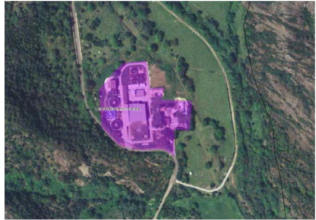
Figura - 13 - Depuratore (Monteleone Roccadoria)
